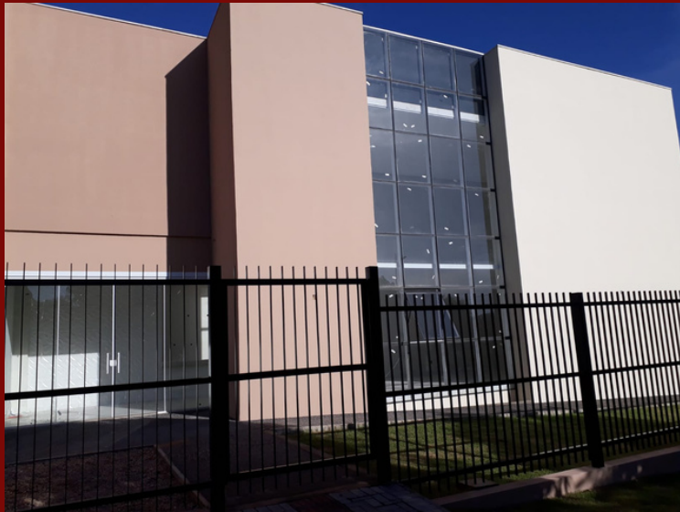
Nova sede da ATMP em fase de finalização
